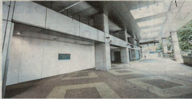
Keadaan sebuah bangunan lama yang kosong dengan notis kerja pembaikan sementara di Jalan Raja Chulan. (Foto Nabila Adlina Azahari/BH)
