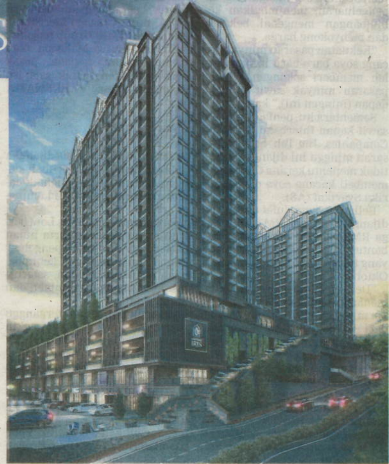
Projek pembangunan kediaman Centrum Iris LBS di Cameron Highlands.
